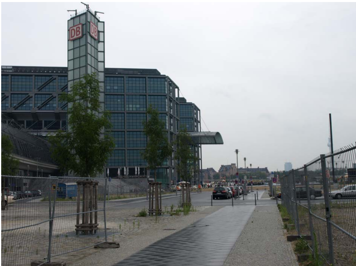
Abb. 1: Blick auf die Südfront des Hauptbahnhofs Berlin am Washingtonplatz.
