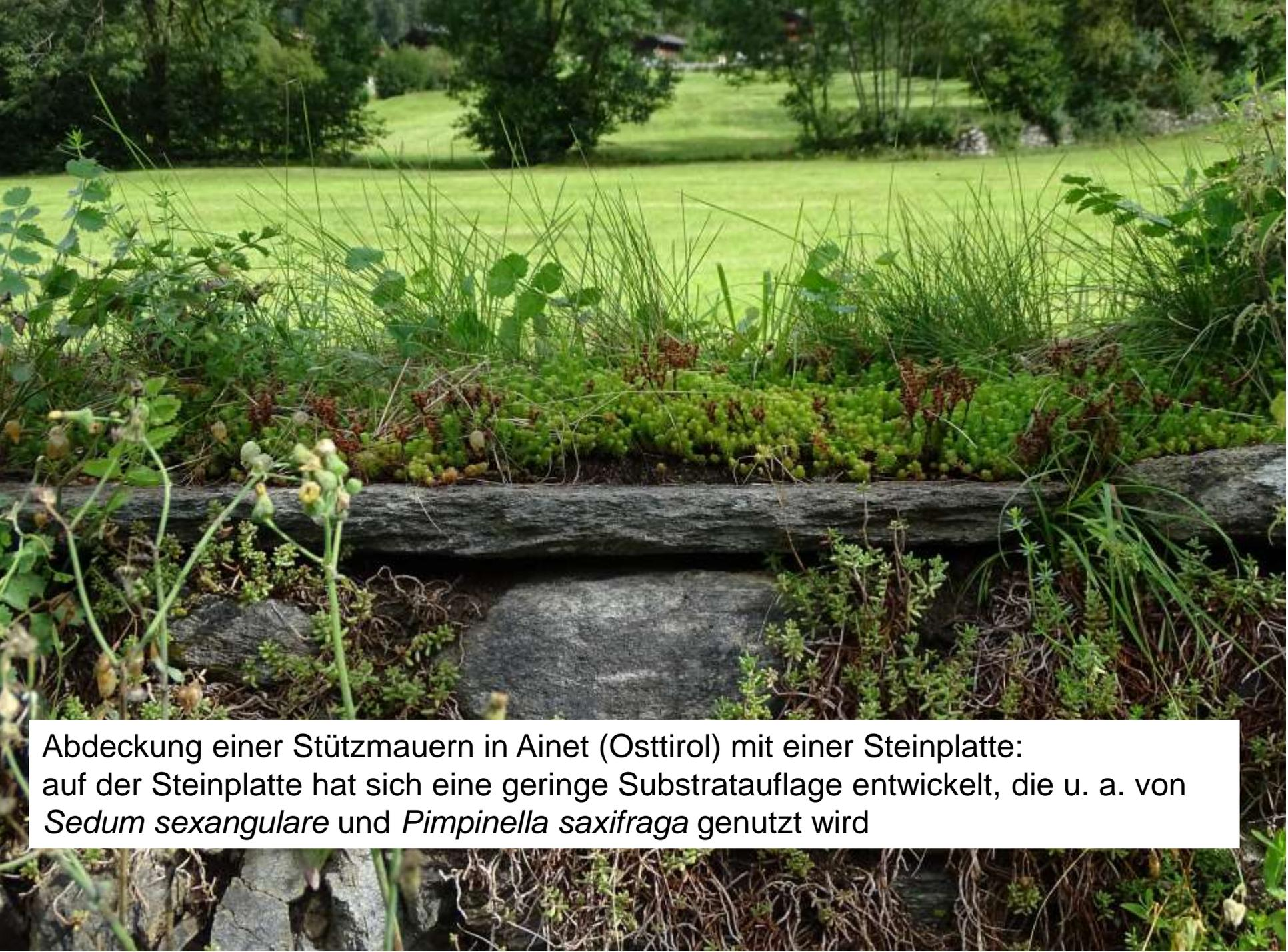
Abdeckung einer Stützmauern in Ainet (Osttirol) mit einer Steinplatte:
