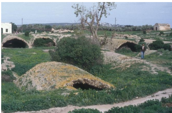
Cisterns of La Malga
