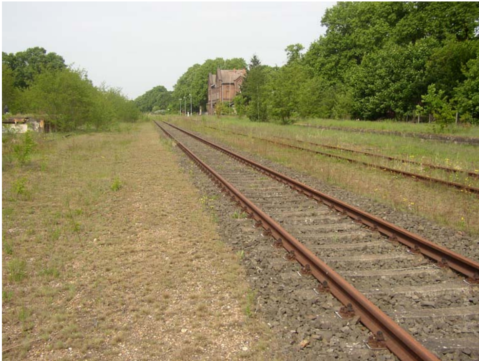
Abb. 1: Blick auf das ehemalige Bahnhofsgelände und Empfangsgebäude von Osten (17.5. 2003).
